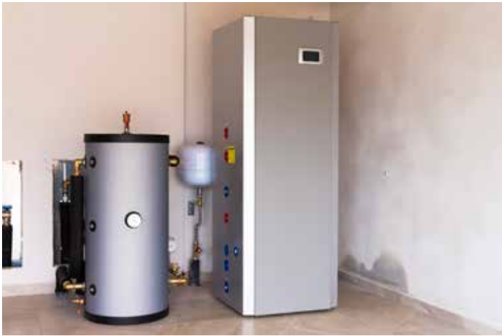
H Ì N H . 4 6 Bơm nhiệt dùng cho điều hòa không khí và đun nước nóng
