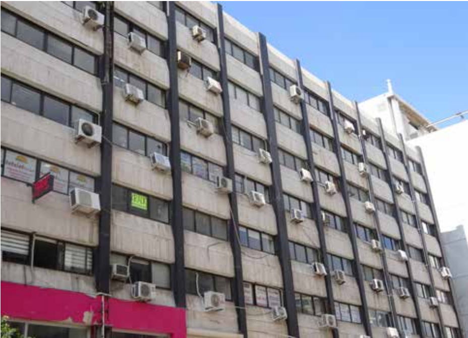
H Ì N H . 1 9 Công trình văn phòng sử dụng hệ thống điều hòa kiểu rời
