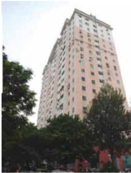
HÌNH . 0 8 Công trình chung cư 17T10 ở Hà Nội
