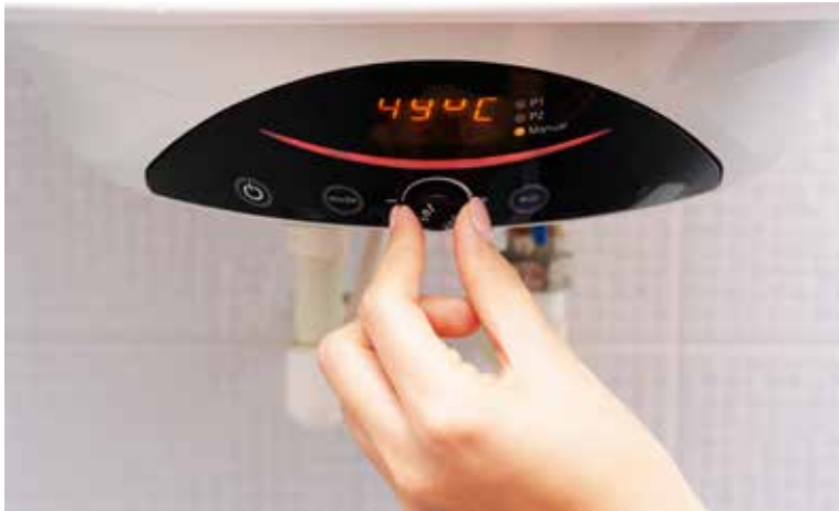
H Ì N H . 4 9 Cài đặt nhiệt độ cho hệ thống cấp nước nóng
