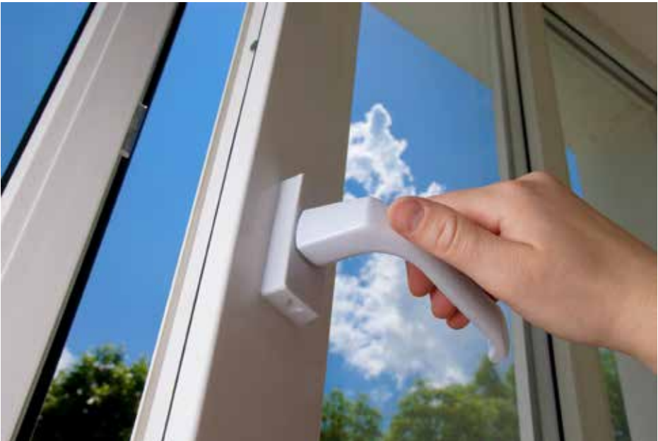
H Ì N H . 1 5 Cửa sổ đóng mở được cần kín khí để ngăn không khí lọt ra ngoài khi bật điều hoà
