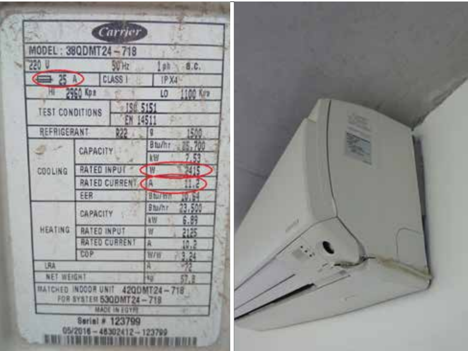
H Ì N H . 2 0 Hiệu suất hệ thống điều hòa không khí thường được ghi trên nhãn máy đính kèm
