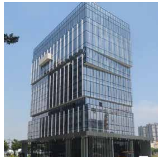
H Ì N H . 5 0 Công trình M-Building
