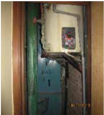
H Ì N H . 6 9 Thiết bị đun nước nóng bằng điện kiểu cũ
